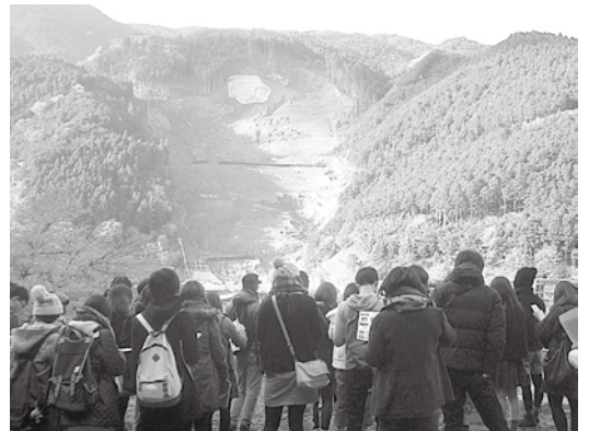
深層崩壊現場(迫地区)を対岸から見る。吉野土木事務所の花本さんから説明を受ける学生たち
